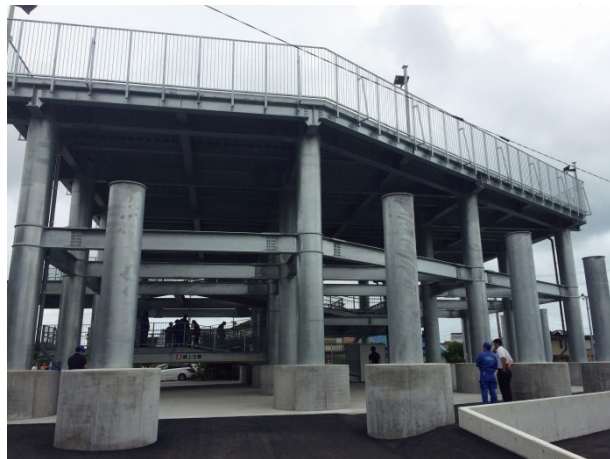
完成した津波避難タワー！ 地域の安全安心を確保！
